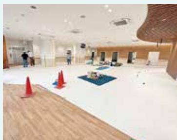
▲正面玄関から見るロビー奥が診察室です
