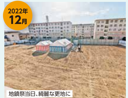
旧・共立診療所の解体から工事がスタート
