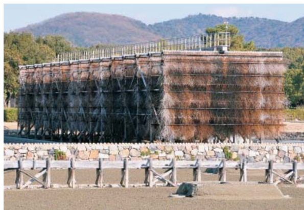
▲海水を蒸発させ、かん水をつくる装置
